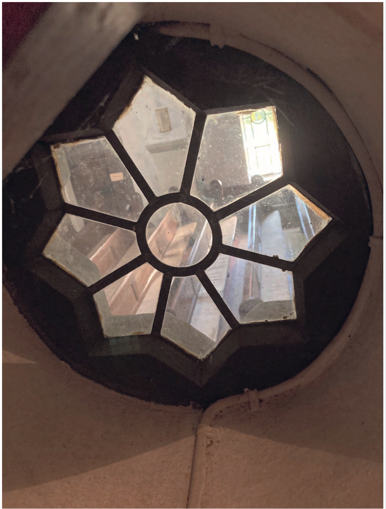
Abb. 12: Sternfenster mit Blick vom Treppenaufgang zur Damenempore auf das Hauptschiff der Klosterkirche mit den Sitzbänken
